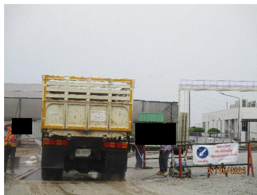
รูปที่ 2-8 การทำความสะอาดล้อรถบรรทุกก่อน ออกจากเขตก่อสร้าง
