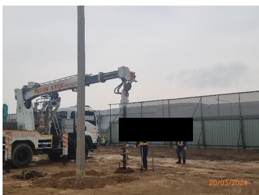
รูปที่ 2-11 วิธีเจาะส่วนำก่อนตอก (Pre-bore)
